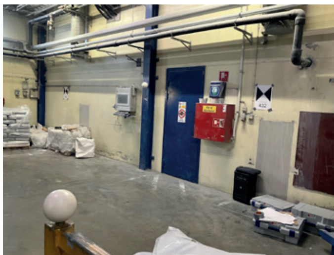
Denna bilden visar olika s.k. referenspunkter som vi använder för att foga ihop alla de olika scanningarna (pilarna på väggen och bollarna på stolparna).
